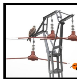
PROTECCIÓ DELS CABLES
